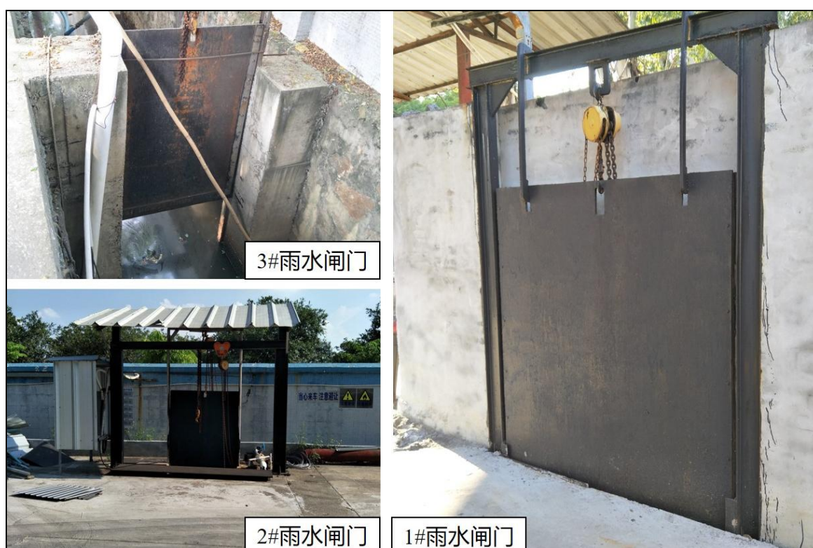
图 6-3 雨水闸门现场情况
