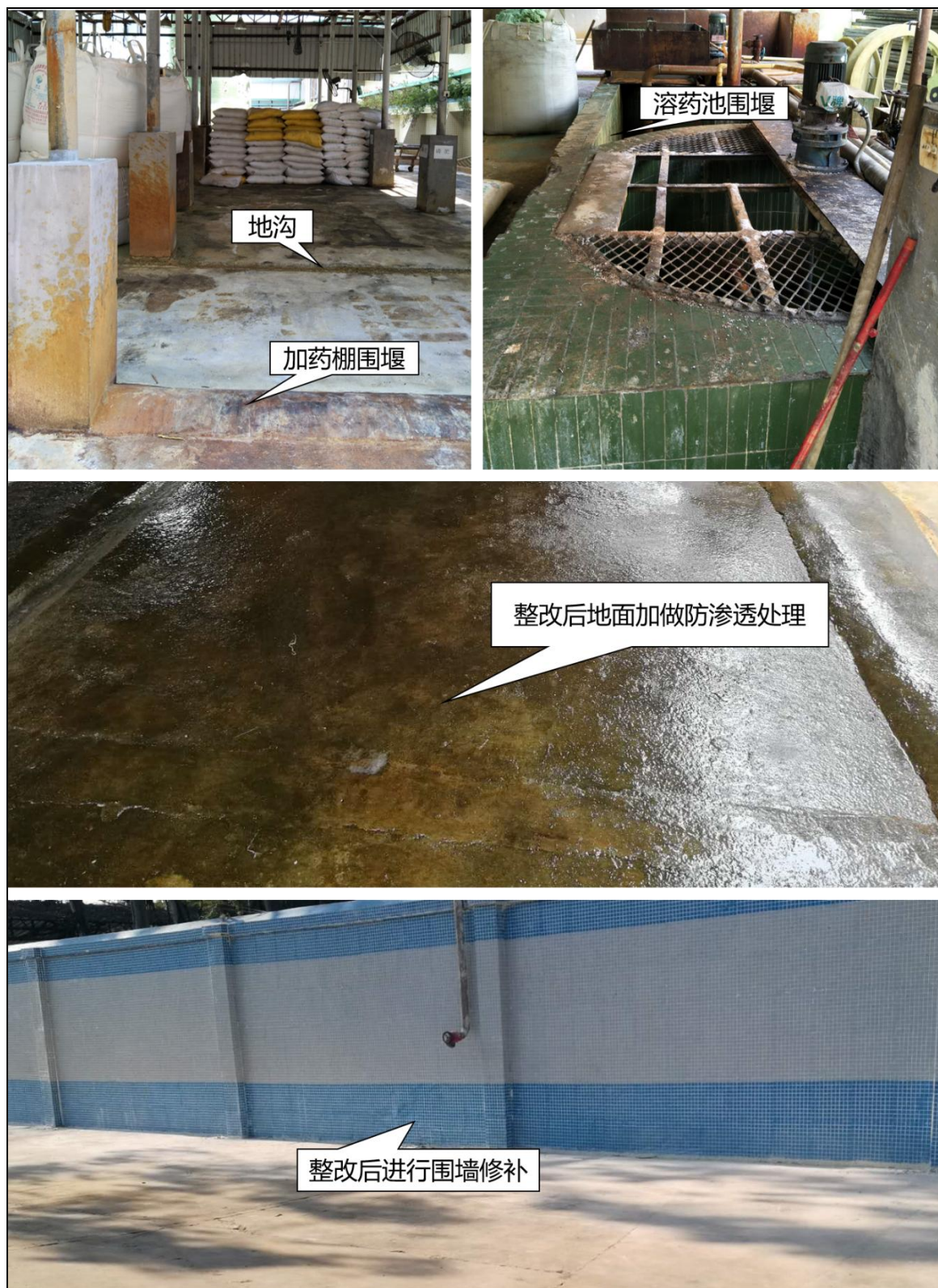
图 5-1 加药棚现场情况
